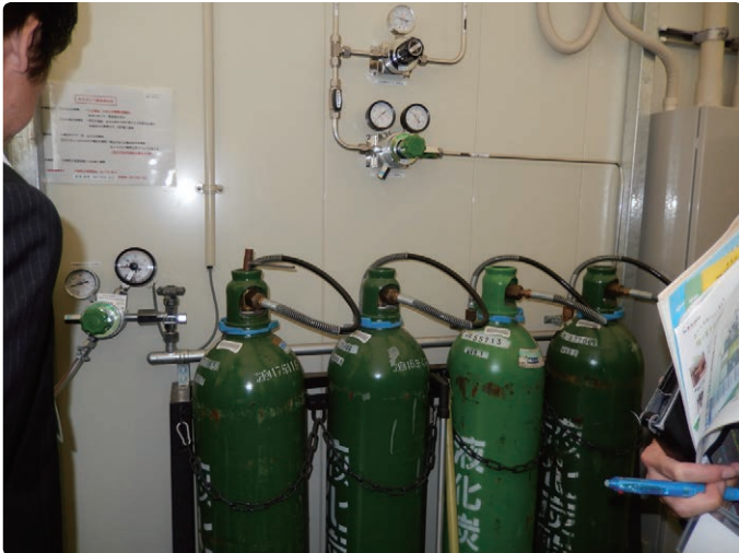
写真3 施用 CO 2 の制御装置
