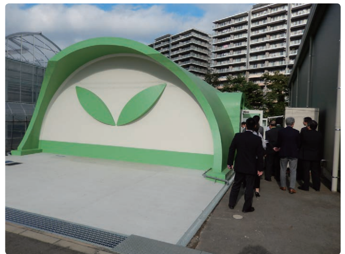
写真1 閉鎖型人工光型植物工場の建屋
