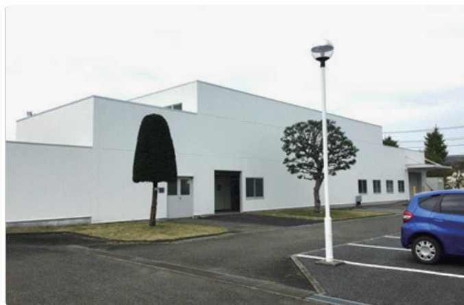
写真2 RAC4が新設される建屋
