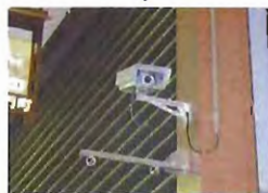
防犯カメラの設置
