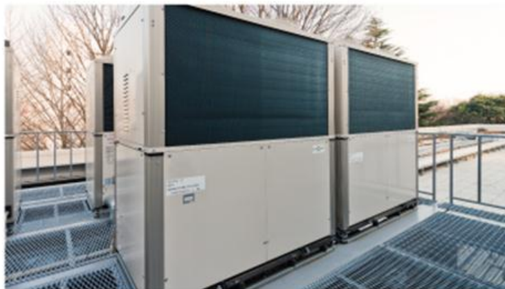
図 2.3.1 室外機設置事例（通常設置）
