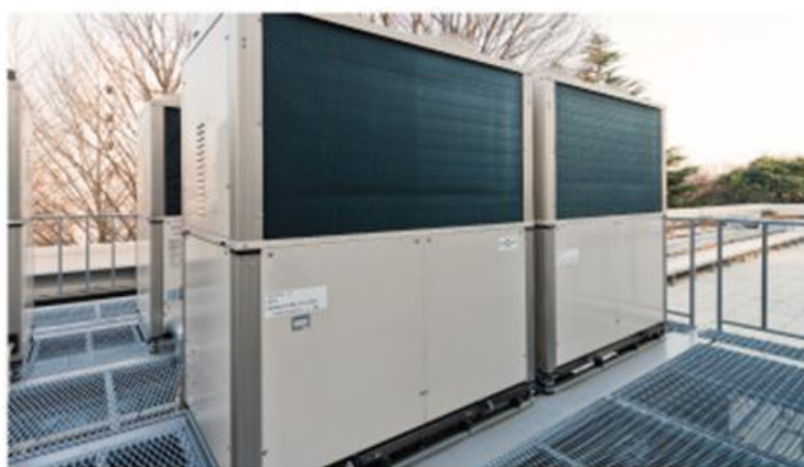
図 2.3.1 室外機設置事例（通常設置）
